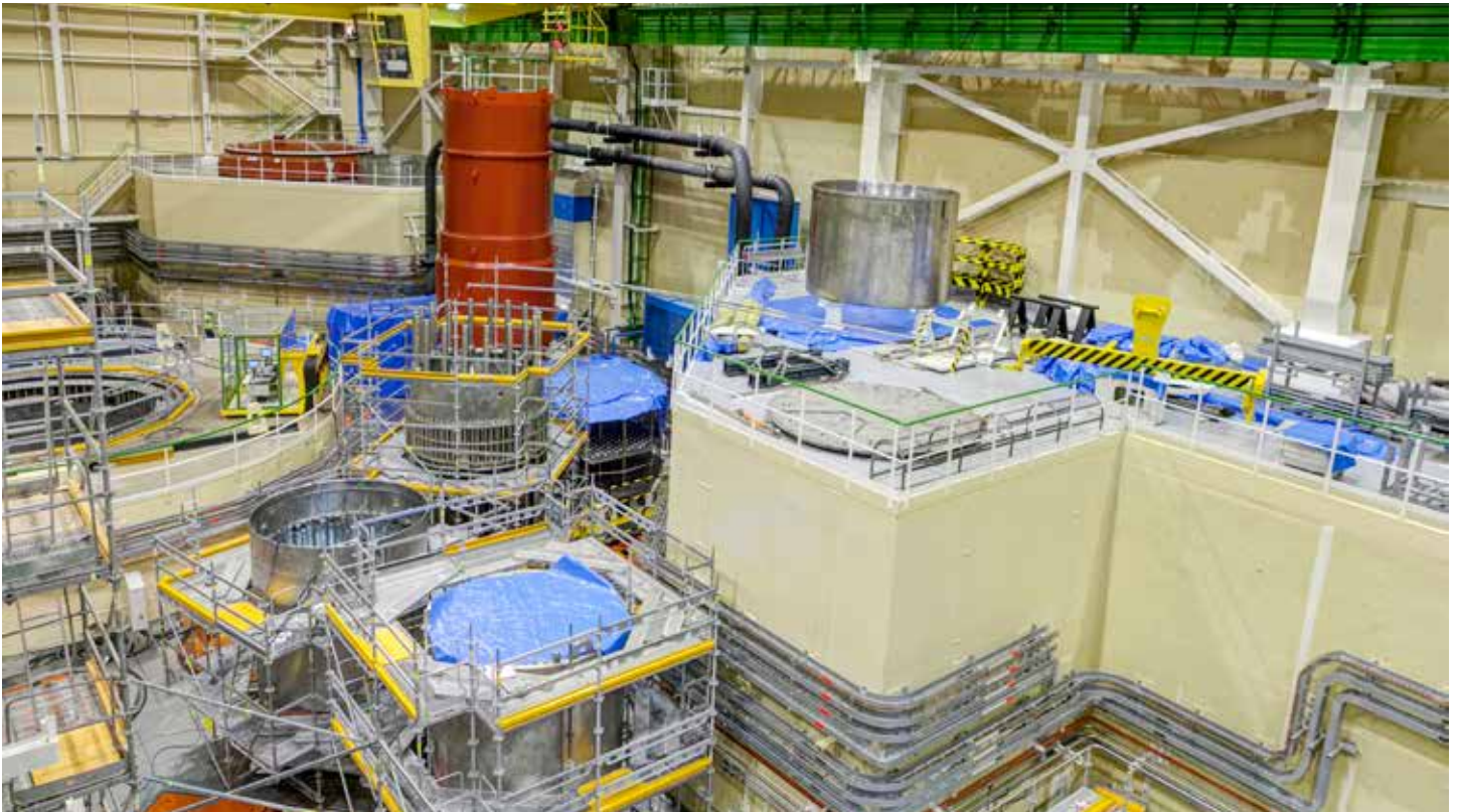
Dokončená renovácia vnútroreaktorových častí na reaktorovej sále 3. bloku.
