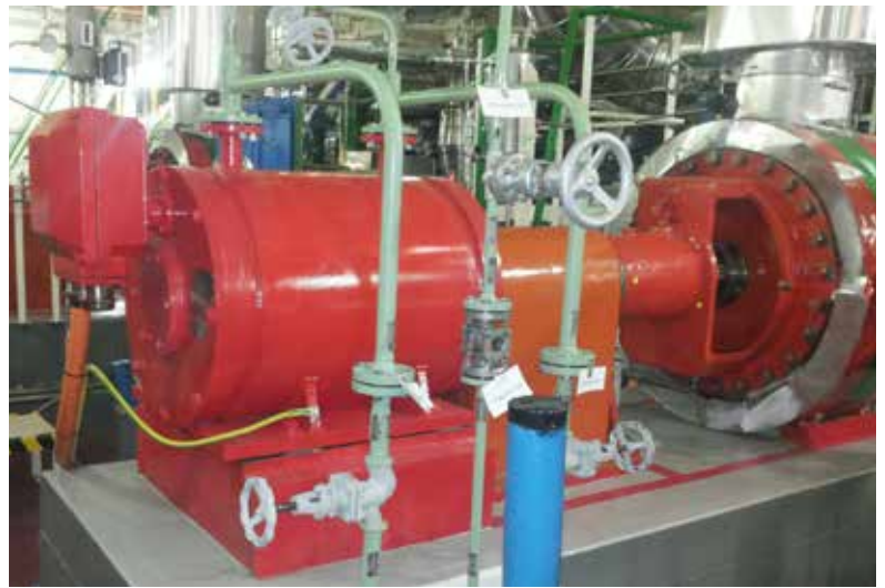
Nový elektromotor sprchového čerpadla s parametrami pre ťažké havárie.
