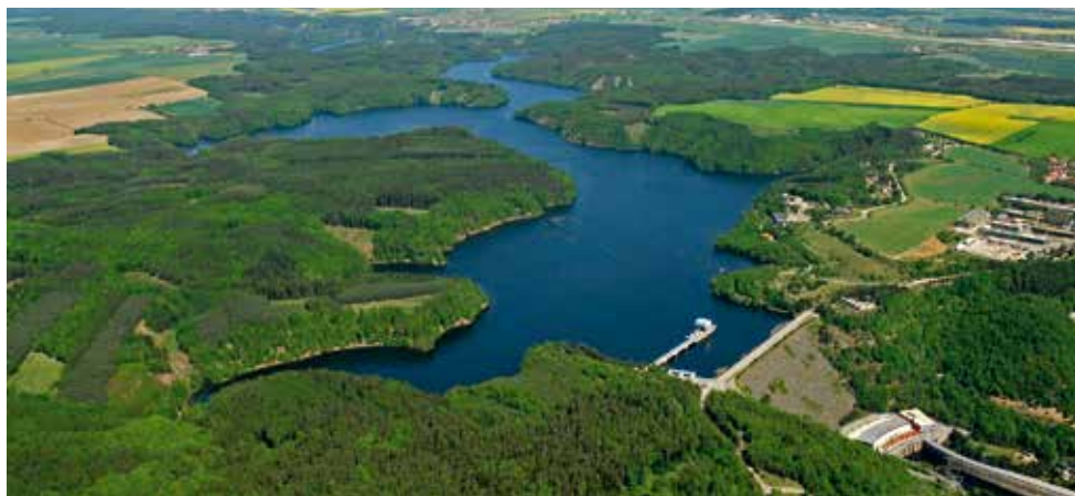
■ Přecherpávací vodní elektrárna Dalešice.
