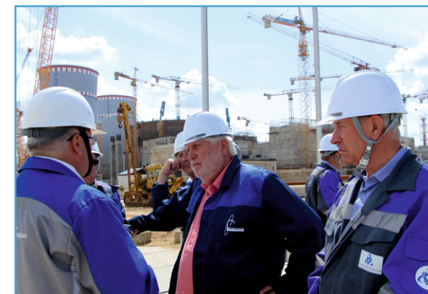
Návštěva jaderných elektráren v Rusku - výstavba Leningradská II
