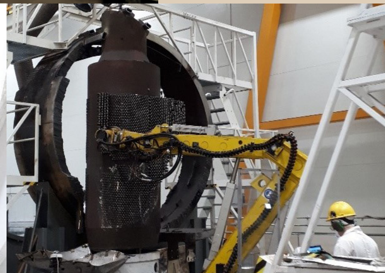
Prvý parogenerátor je v poslednej fáze fragmentácie, zostáva rozrezať časť plášťa a kolektor.
