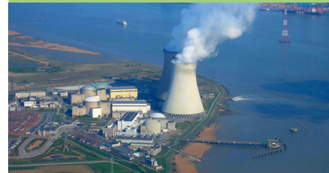
Jadrová elektráreň Doel.
