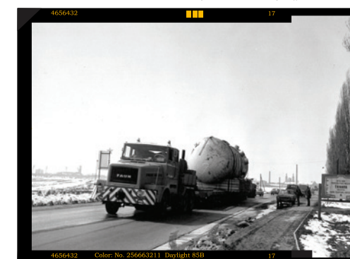
Preprava tlakovej nádoby reaktora cez sídlo okresu v roku 1977.
