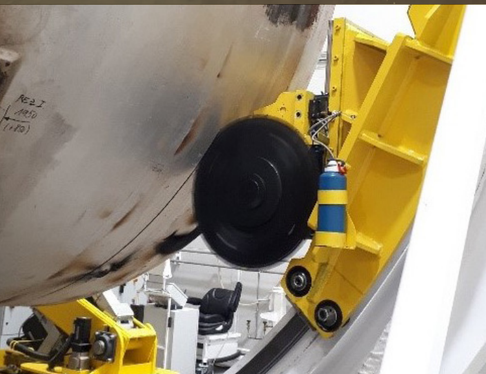
Prvý rez do plášťa parogenerátora PG11.
