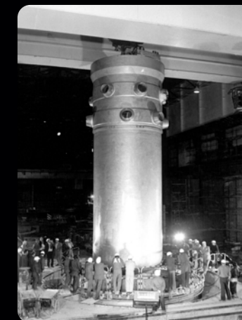
Osadenie do šachty reaktora
