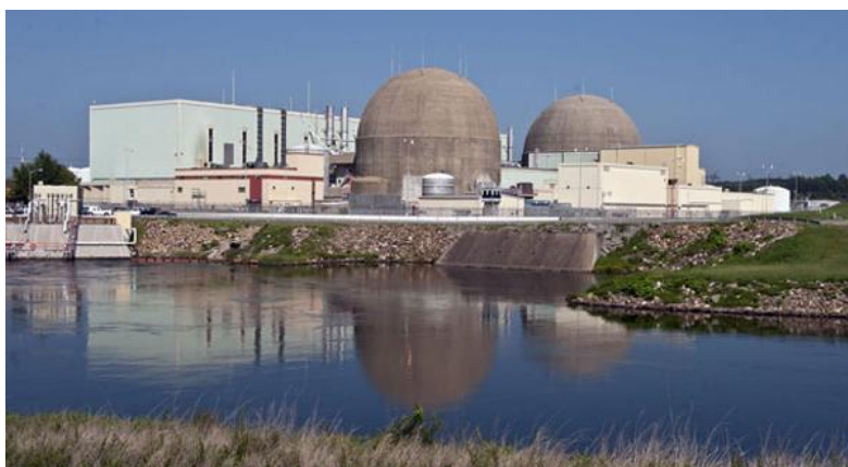
Jaderná elektrárna North Anna
