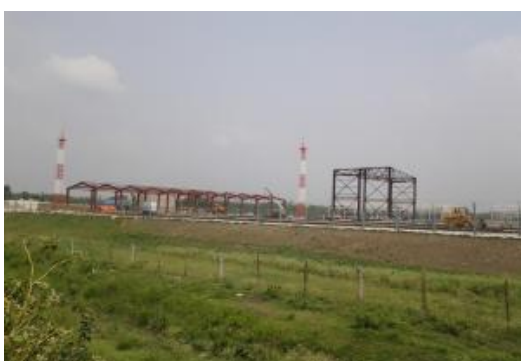
Staveniště budoucí jaderné elektrárny Rooppur dnes – stojí základy pomocných budov.
