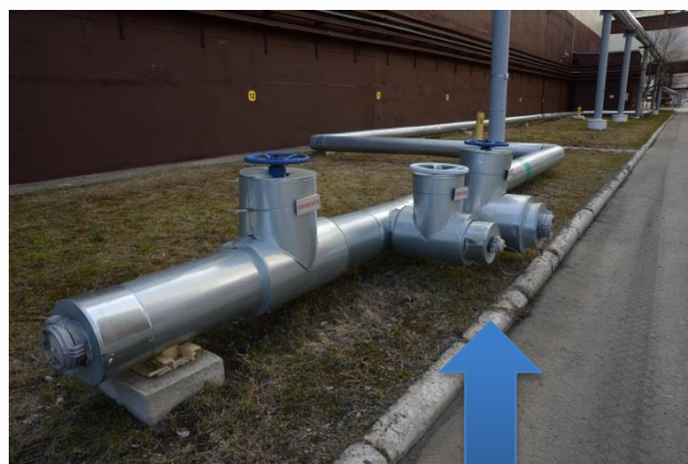
Systém hašení požárů
