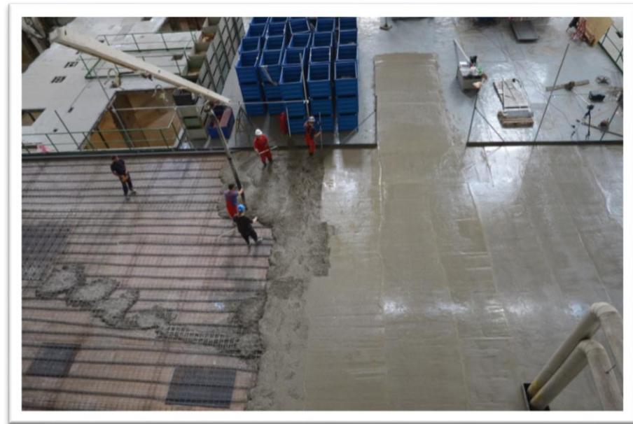
Betonáž rozšíreného kontrolovaného pásma v strojovni
