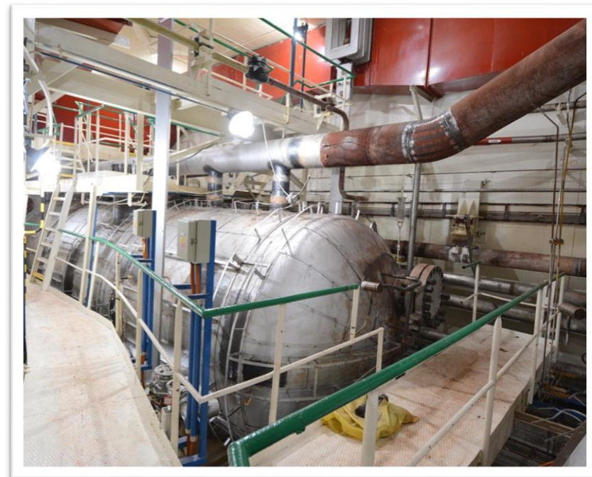
Stav po demontáži izolácií
