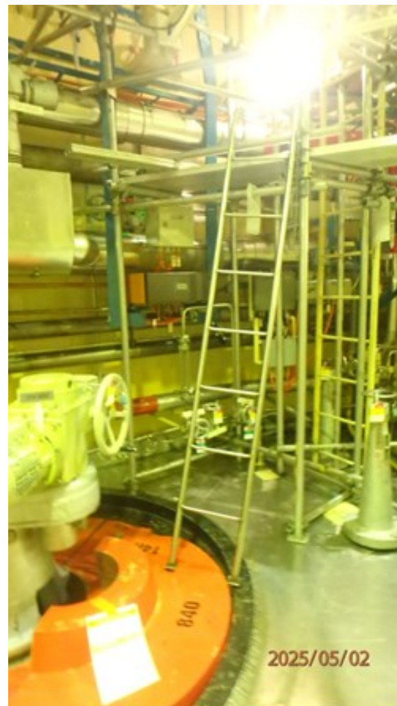
KP 3. RB, kontakty lešení s technologií (m. č. 301 HCČ 2, ocelový žebřík na stínění HUA, u KO, lešení instalováno přímo na montované technologii odvodu vodíku...
