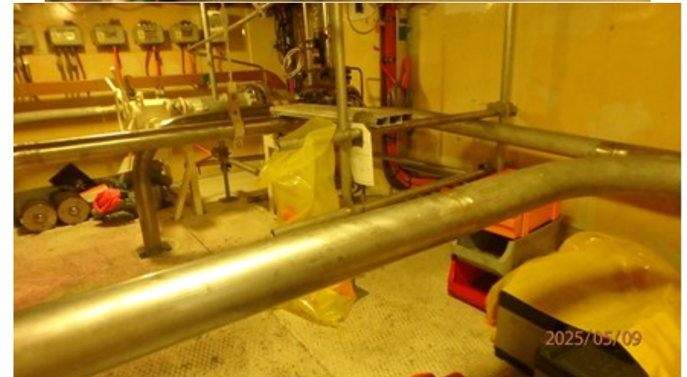
KP 3. RB, kontakty lešení s technologií (m. č. 301 HCČ 2, ocelový žebřík na stínění HUA, u KO, lešení instalováno přímo na montované technologii odvodu vodíku...
