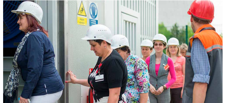
Ženy při prohlídce záložního dieselgenerátoru AAC DG
