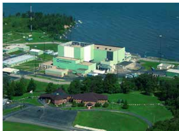
▲ Jaderná elektrárna Ginna, New York
