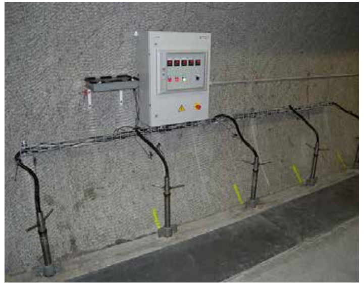
▲ Korozní zkouška v podzemní laboratoři Grimsel Test Site, v rámci projektu MACOTE
